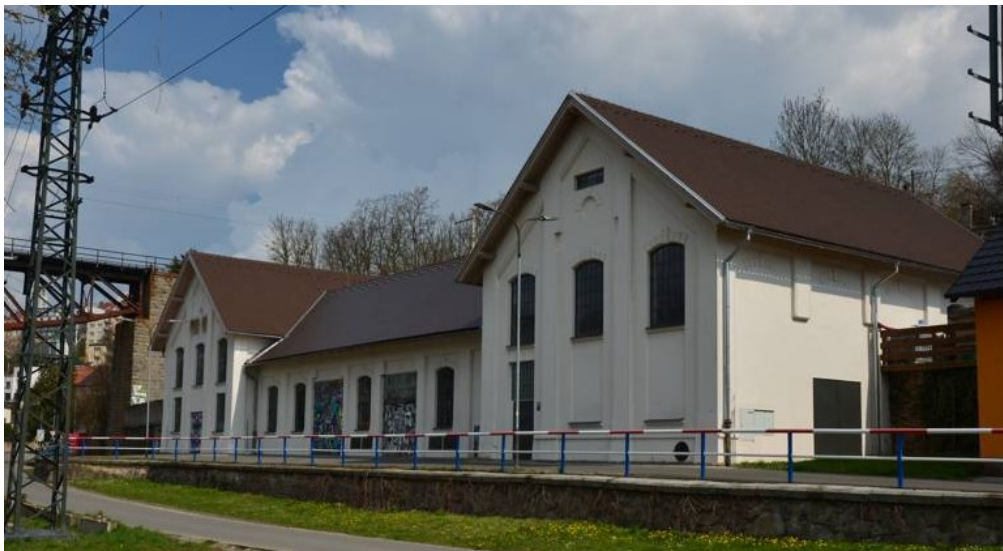
Obrázek č. 1: Budova železniční elektrárny v Táboře Zdroj: [3]
