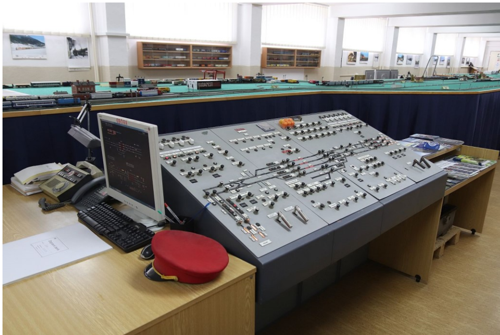
Obrázek 6 – reléové zabezpečovací zařízení:
